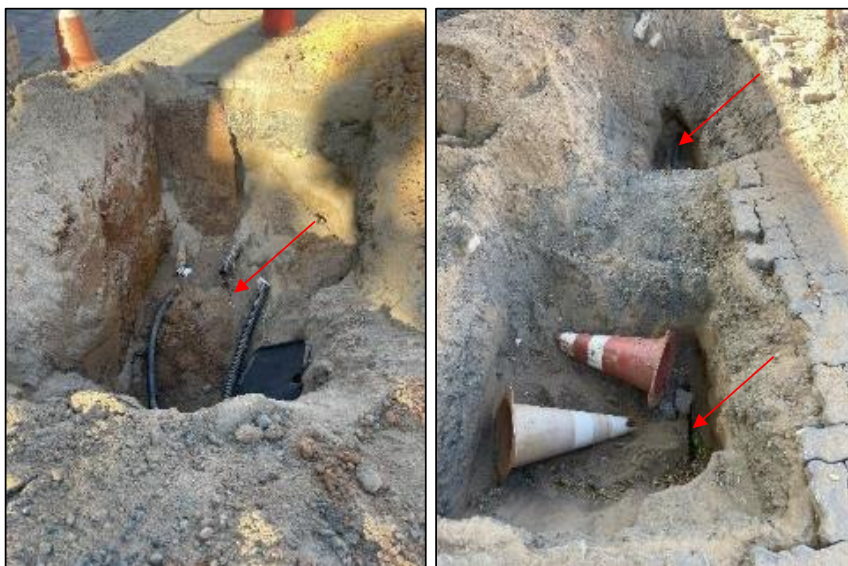
Figura 45: Abertura de valas para instalação do cabeamento de fibra óptica (foto data: 05/06/2023).
