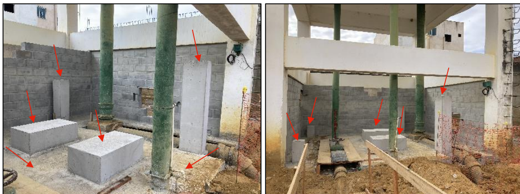
Figura 81: Bases para bombas da Estação Elevatória (foto data: 05/07/2023).
