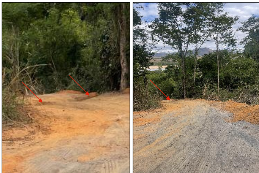
Figura 78: Canaletas de drenagem na estrada de acesso à área do STA (foto data: 05/07/2023).
