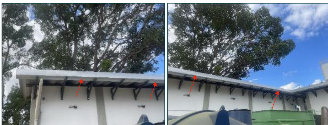
Figura 61: Calhas de drenagem de água pluvial (foto data: 06/06/2023).
