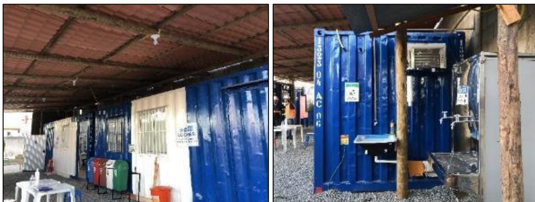
Figura 91: Containers de apoio instalados na área coberta do canteiro (foto data: 05/06/2023).
