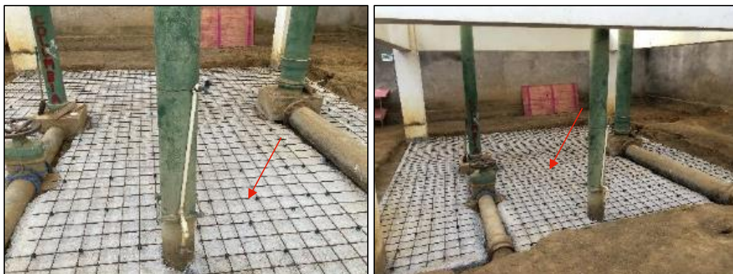
Figura 98: Concreto de regularização e armação da base da Estação Elevatória (foto data: 05/06/2023).
