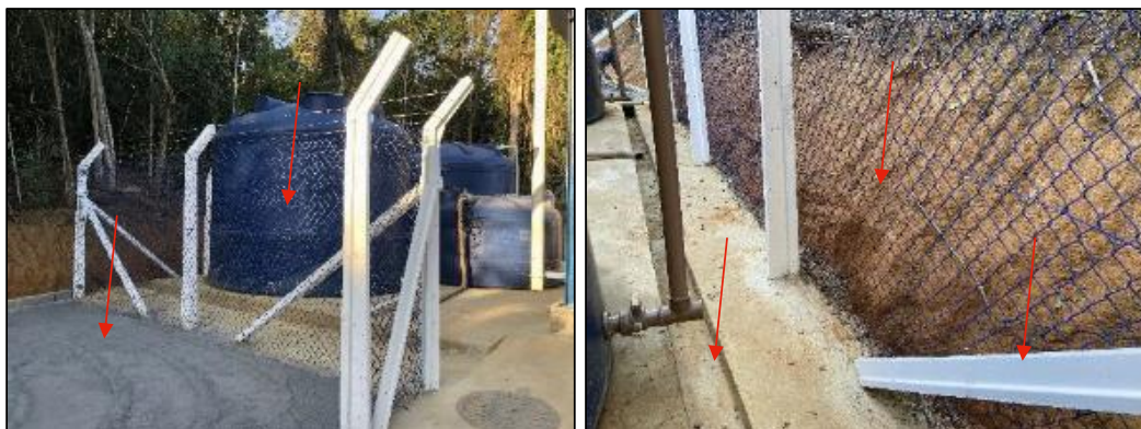
Figura 82: Cercamento da região do STA e canaleta de drenagem (foto data: 05/06/2023).
