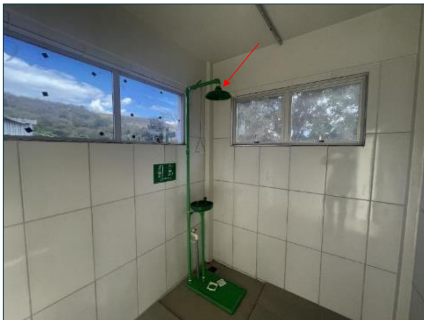
Figura 66: Instalação do chuveiro lava olhos (foto data: 06/06/2023).
