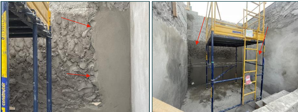
Figura 41: Execução de chapisco, emboço e reboco na alvenaria interna do abrigo do sistema de pré-cloração (foto data: 05/07/2023).
