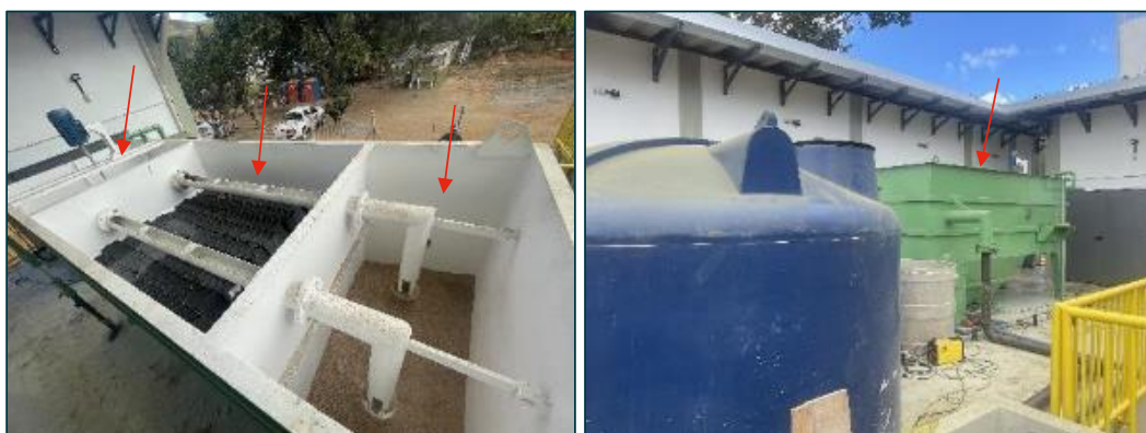
Figura 58: Instalação da ETA compacta (foto data: 06/06/2023).
