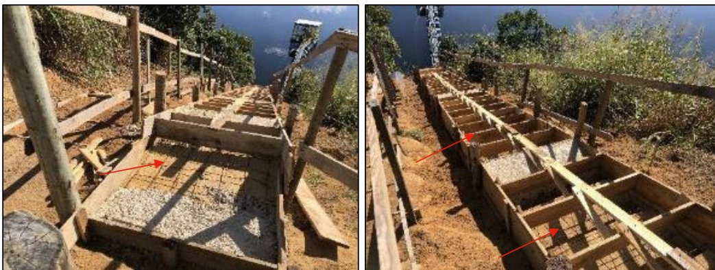
Figura 53: Vista superior da escada provisória com forma e armação (foto data: 05/06/2023).
