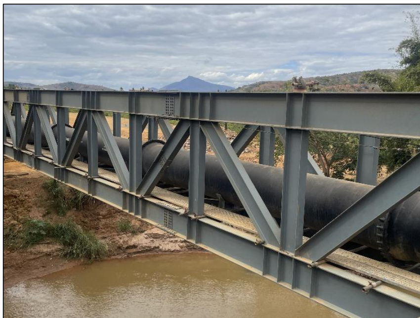
Figura 51: Instalação do “pipe rack 3” concluída (foto data: 06/07/2023).
