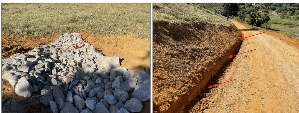
Figura 72: Vala de drenagem (à direita) e enrocamento (à esquerda) na estrada de acesso ao STA (foto data: 04/07/2023).
