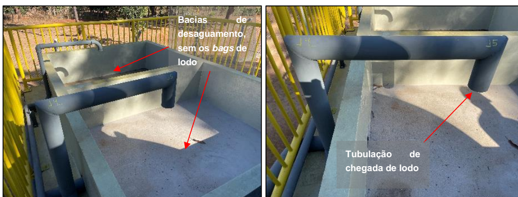
Figura 23: Bacias para desaguamento do lodo da ETA, sem a presença dos bags de lodo (foto data: 06/07/2023).
