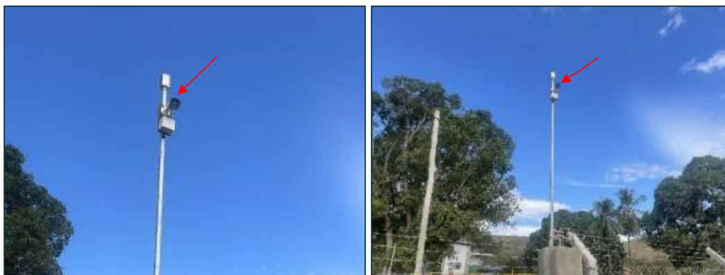
Figura 65: Instalação do sistema de vídeo monitoramento (foto data: 06/06/2023).
