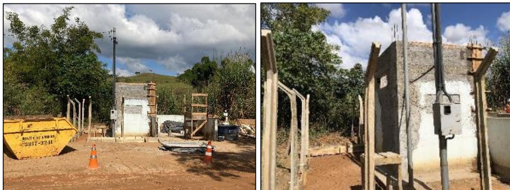
Figura 74: Visão frontal das obras no abrigo elétrico do poço Beira Rio (foto data: 01/06/2023).
