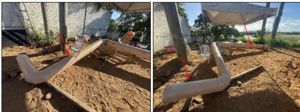
Figura 51: Montagem de trecho da adutora de água bruta nas proximidades da ETA Vila Isa (foto data: 05/06/2023).
