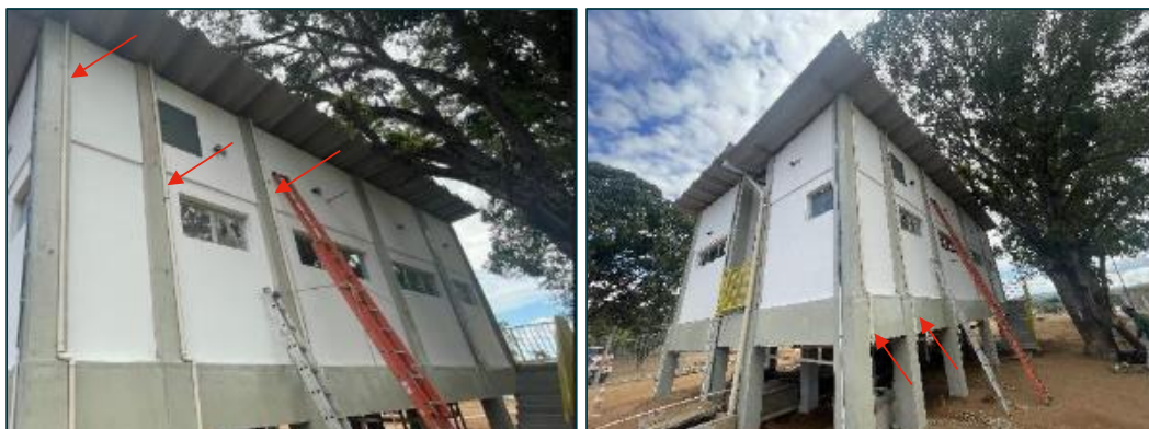
Figura 57: Instalação das tubulações de ventilação do sistema hidrossanitário (foto data: 06/06/2023).
