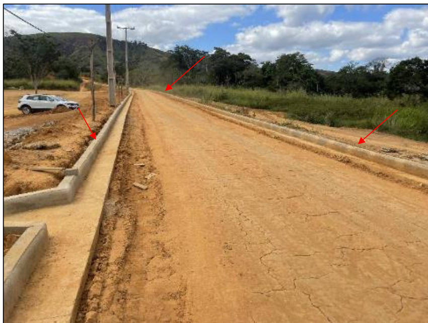
Figura 42: Meio fio instalado no acesso da captação alternativa (foto data: 05/06/2023).
