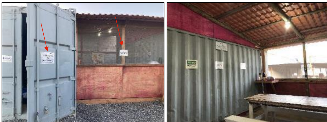
Figura 92: Depósito de materiais e refeitório (foto data: 05/06/2023).
