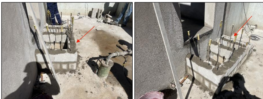
Figura 70: Execução da escada de acesso para acesso ao abrigo do painel elétrico no poço Beira Rio (foto data: 04/07/2023).
