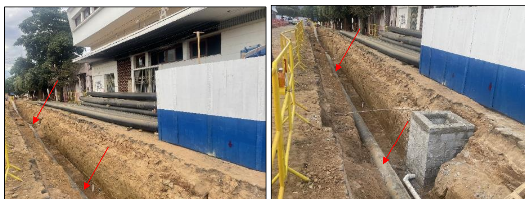
Figura 66: Assentamento da tubulação do Sistema Alternativo de Captação e Adução (foto data: 05/07/2023).
