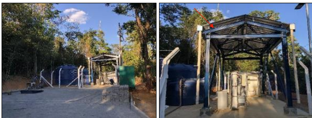
Figura 81: Visão geral da área do STA e detalhe da estrutura metálica (foto data: 05/06/2023).
