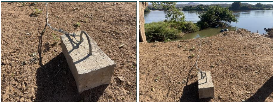
Figura 60: Blocos de ancoragem dos flutuantes (foto data: 05/07/2023).
