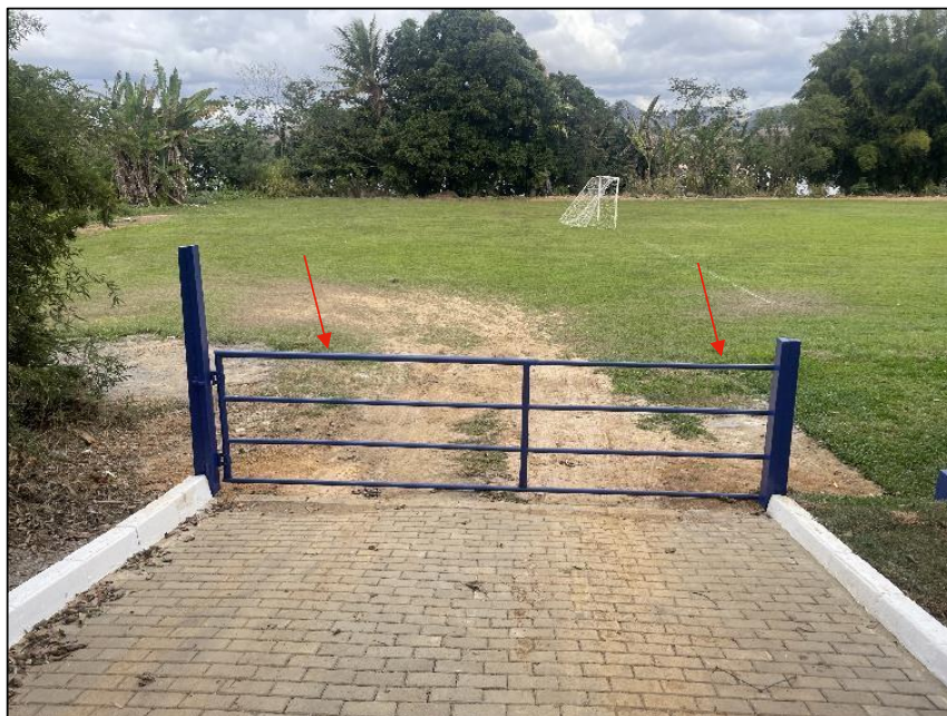
Figura 76: Portão de acesso de veículos na área do poço profundo (foto data: 05/07/2023).
