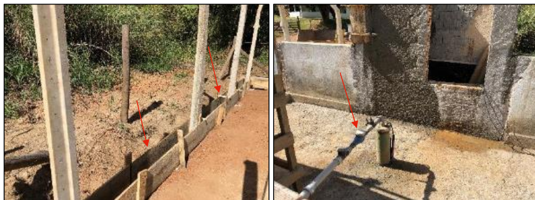
Figura 76: Forma para concretagem de base dos pilaretes do cercamento da área, à esquerda, e retrato do poço Beira Rio, à direita (foto data: 01/06/2023).
