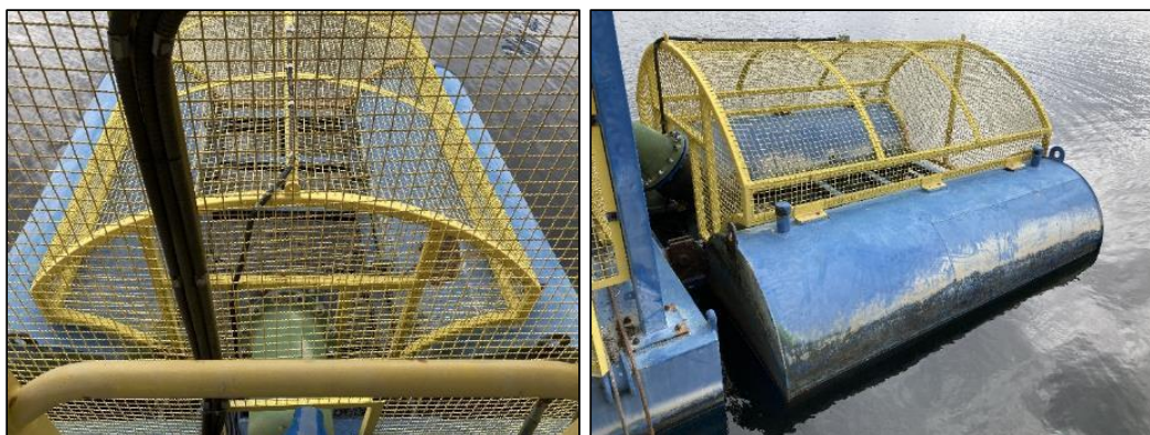
Figura 57: Bomba de 100L/s posicionada e instalada junto a balsa de captação (foto data: 05/07/2023).
