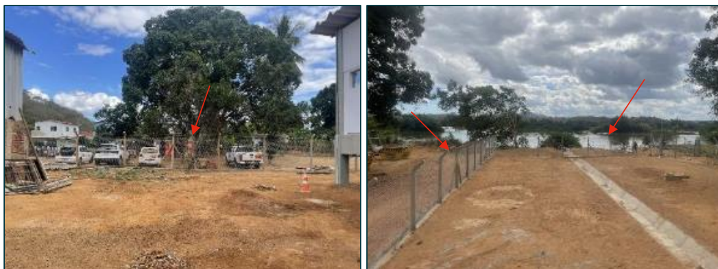
Figura 60: Cercamento da área da nova Estação de Tratamento de Água (foto data: 06/06/2023).
