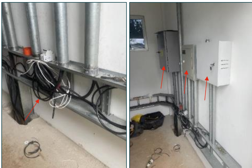
Figura 62: Passagem dos cabos elétricos, à esquerda, e instalação dos quadros elétricos, à direita, na sala elétrica (foto data: 06/06/2023).
