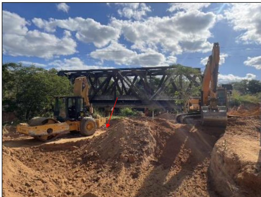
Figura 46: Execução da sub base para posicionamento do guindaste (foto data: 05/06/2023).
