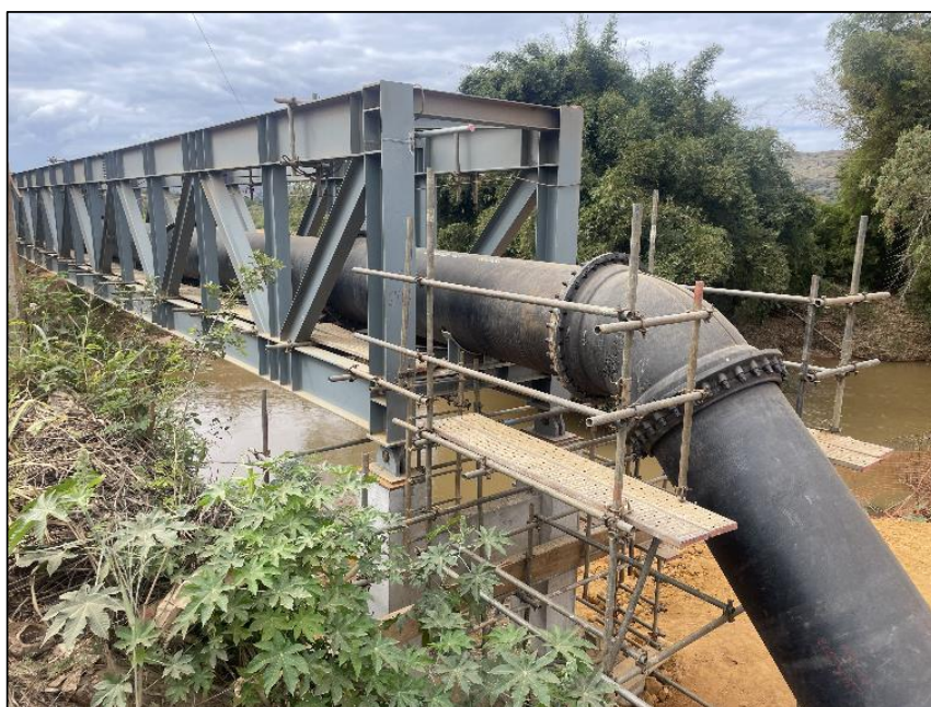
Figura 50: Instalação do "pipe rack 3" concluída (foto data: 06/07/2023).
