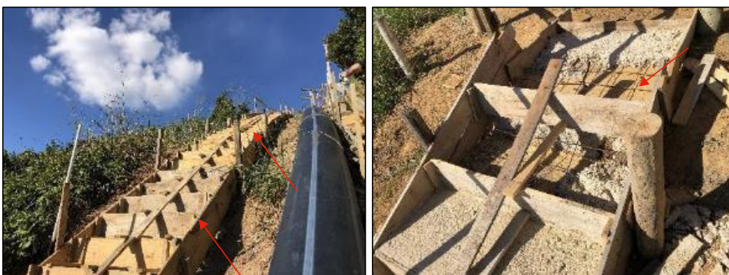
Figura 54: Vista inferior da escada provisória com forma e armação (foto data: 05/06/2023).
