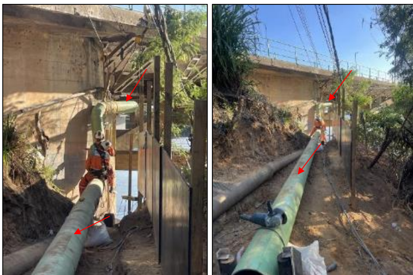
Figura 50: Instalação de trecho da adutora de água bruta nas proximidades da ETA Vila Isa (foto data: 05/06/2023).
