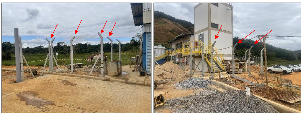
Figura 48: Instalação do cercamento da área da captação alternativa (foto data: 06/07/2023).
