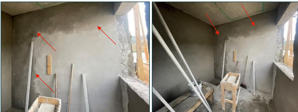
Figura 42: Processo de cura do reboco na alvenaria interna do abrigo do sistema de pré-cloração (foto data: 05/07/2023).
