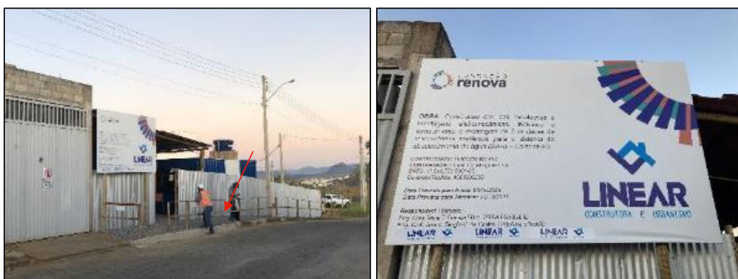
Figura 90: Visão externa ao canteiro de obras e placa de responsabilidade técnica da obra (foto data: 05/06/2023).
