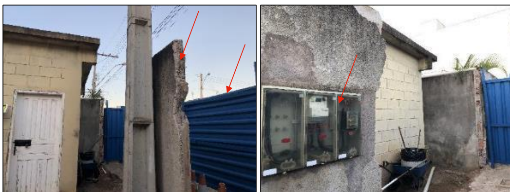
Figura 96: Muro frontal parcialmente demolido, quadros elétricos e tapume metálico (foto data: 05/06/2023).
