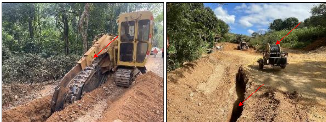
Figura 44: Abertura de valas para instalação do cabeamento de fibra óptica (foto data: 05/06/2023).
