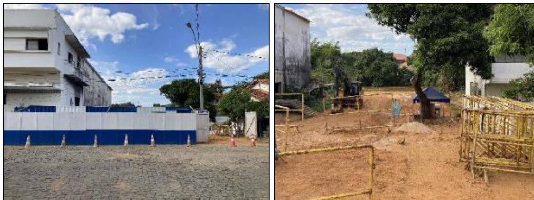
Figura 71: Vista externa e vista interna da área de obras da captação alternativa (foto data: 06/06/2023).
