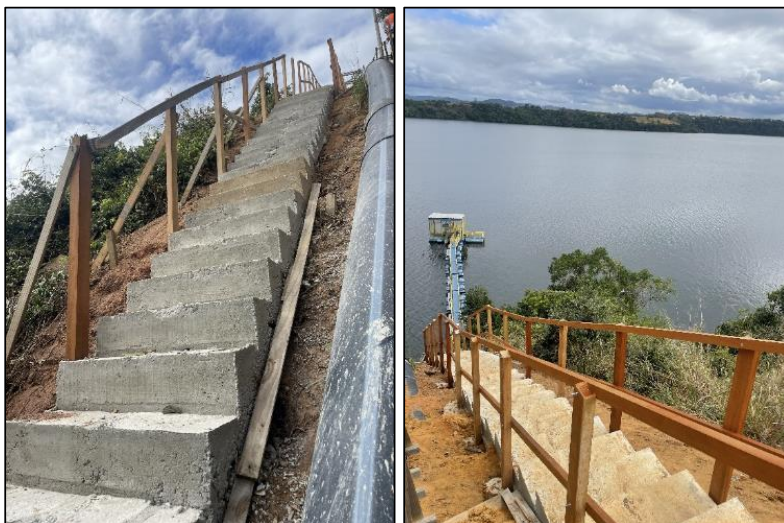
Figura 56: Vista da escada provisória e corrimão parcialmente executado (foto data: 05/07/2023).
