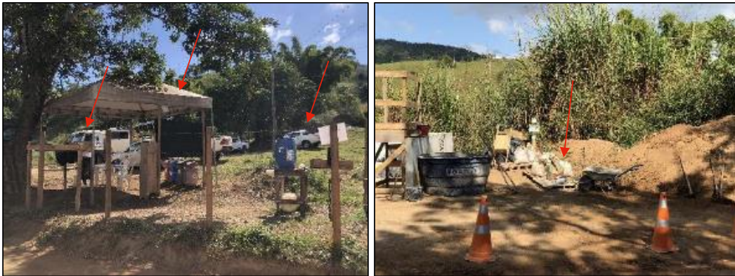
Figura 77: Área de vivência e estacionamento, à esquerda, e materiais de uso da obra, à direita (foto data: 01/06/2023).
