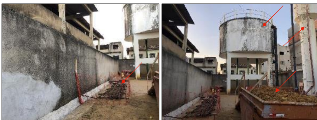
Figura 94: Armazenamento de materiais de obra, caçamba de entulhos e reservatórios existentes (foto data: 05/06/2023).
