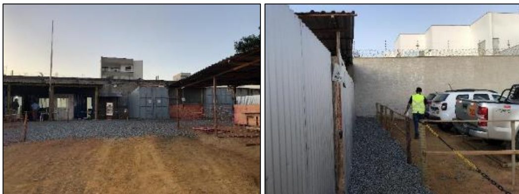
Figura 89: Visão geral do canteiro de obras, à esquerda, e estacionamento, à direita (foto data: 05/06/2023).
