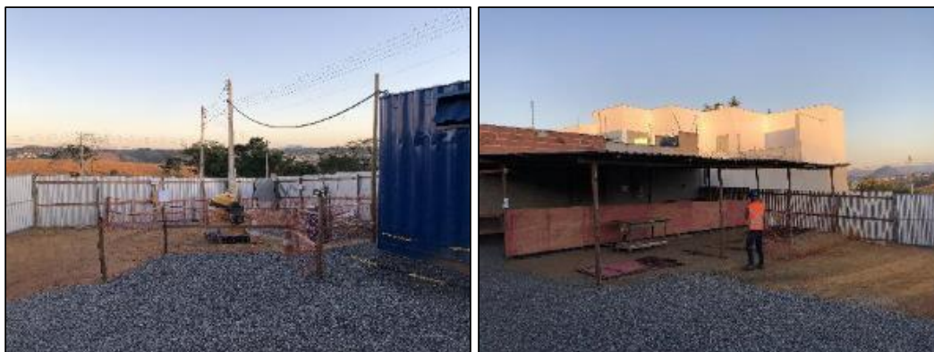
Figura 88: Visão geral do canteiro de obras (foto data: 05/06/2023).
