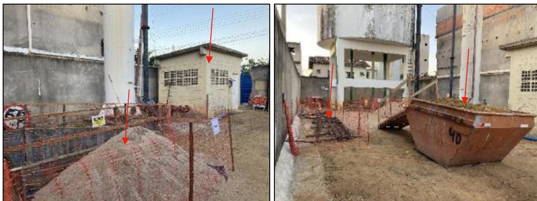
Figura 95: Armazenamento de materiais de obra, caçamba de entulhos e estação elevatória de água (foto data: 05/06/2023).
