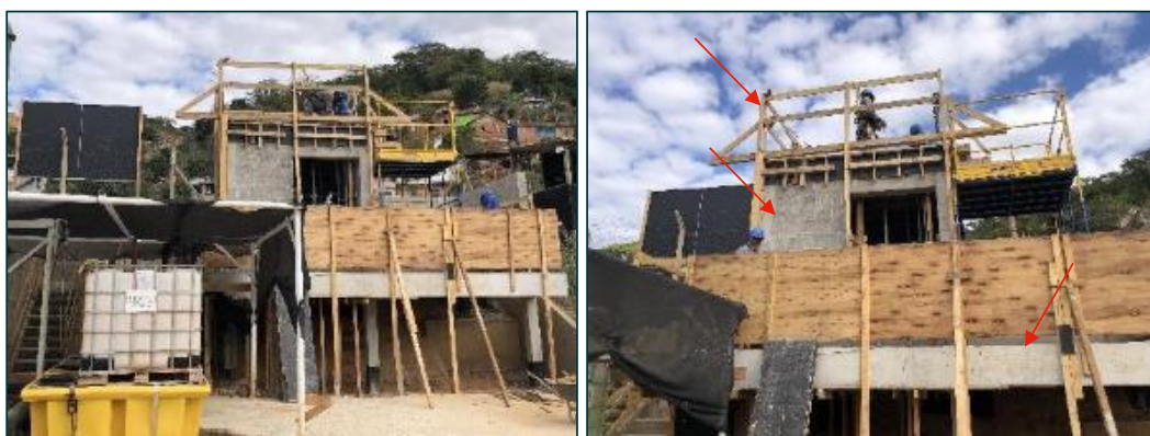
Figura 34: Visão da fachada do abrigo do sistema de pré-cloração (foto data: 06/06/2023).
