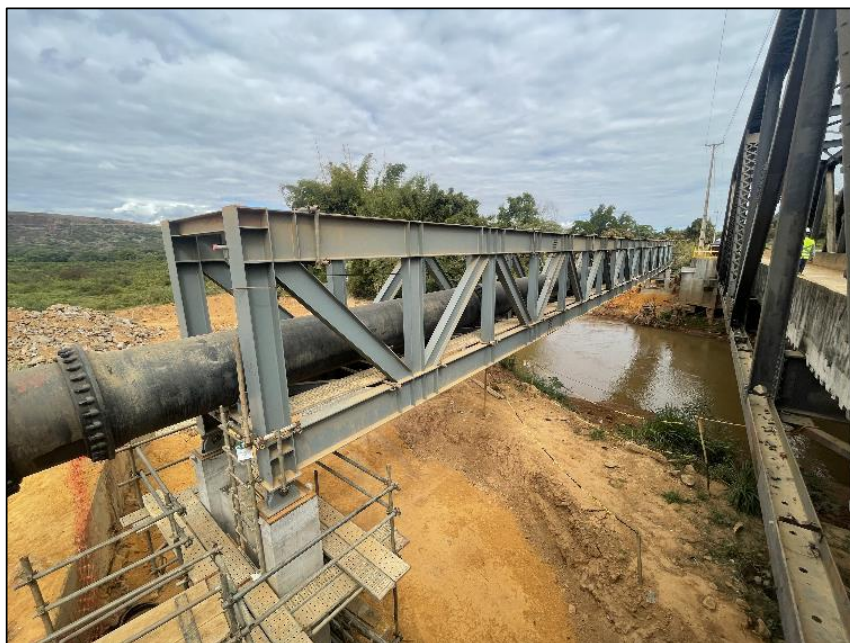
Figura 49: Instalação do "pipe rack 3" concluída (foto data: 06/07/2023).
