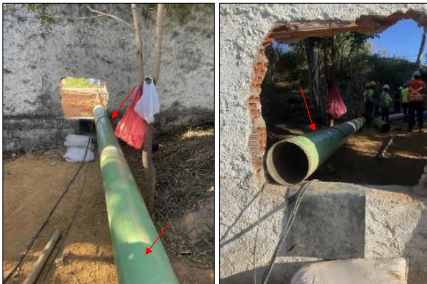
Figura 49: Instalação de trecho da adutora de água bruta nas proximidades da ETA Vila Isa (foto data: 05/06/2023).
