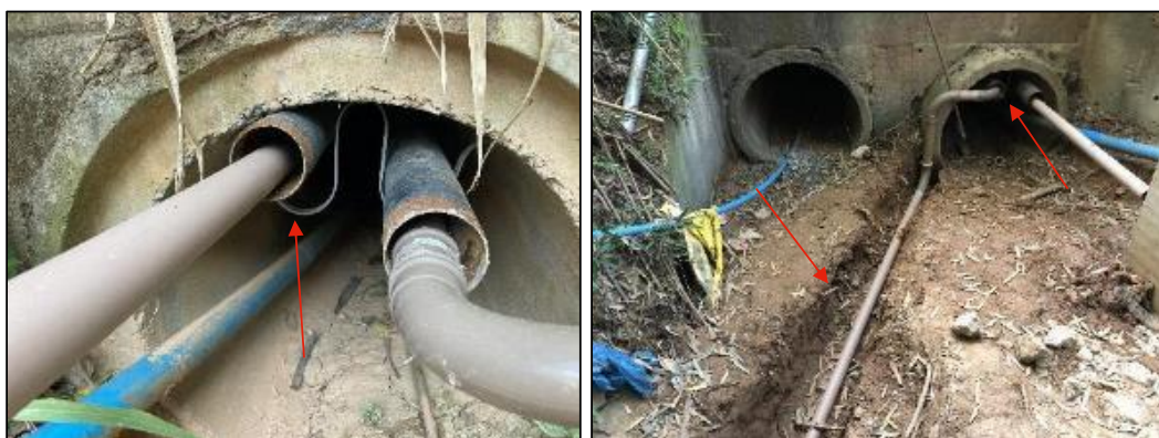
Figura 80: Travessia da tubulação sob a rodovia ES-248 (foto data: 05/06/2023).
