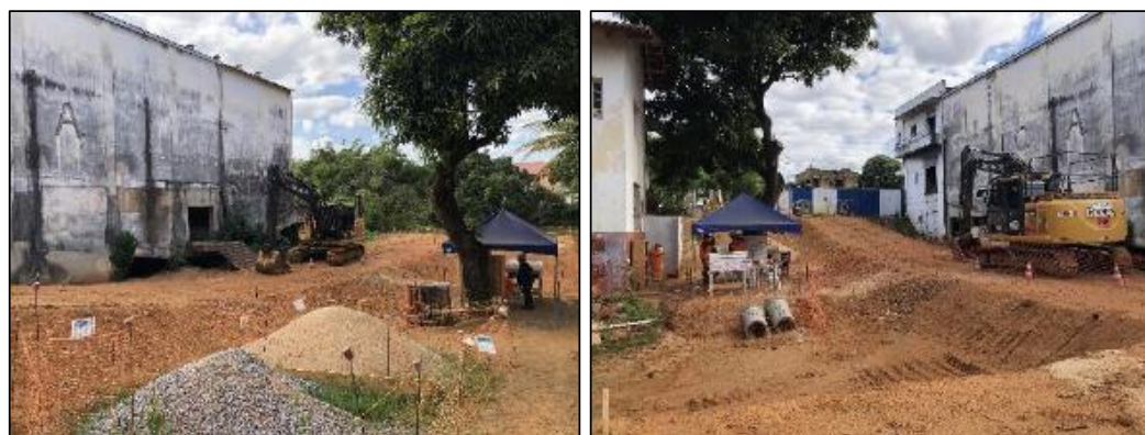
Figura 72: Vista interna da área de obras da captação alternativa (foto data: 06/06/2023).
