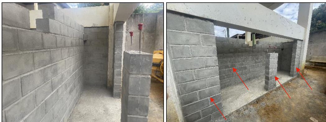
Figura 82: Alvenaria da área do abrigo dos painéis elétricos (foto data: 05/07/2023).
