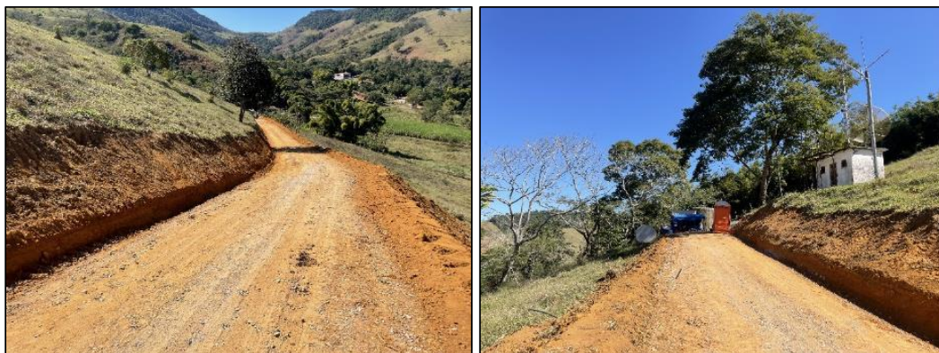
Figura 71: Acesso à área do STA (foto data: 04/07/2023).
