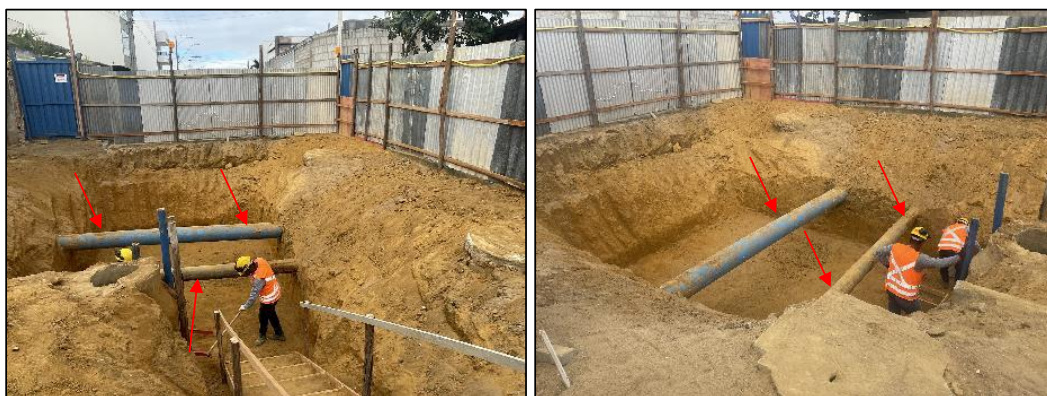
Figura 80: Escavação para execução da caixa de válvulas (foto data: 05/07/2023).
