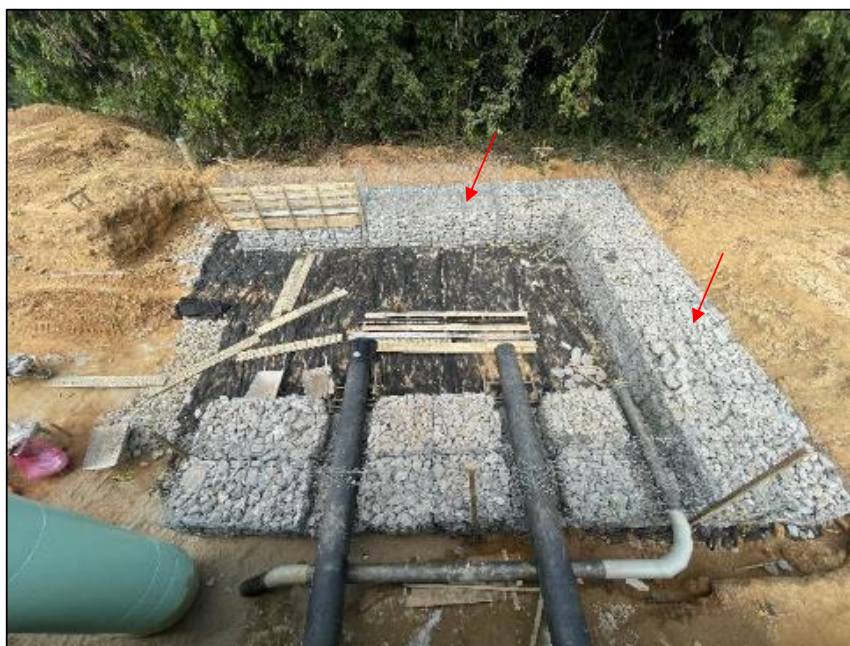
Figura 41: Execução do gabião no tanque de sedimentação do desarenador (foto data: 05/06/2023).
