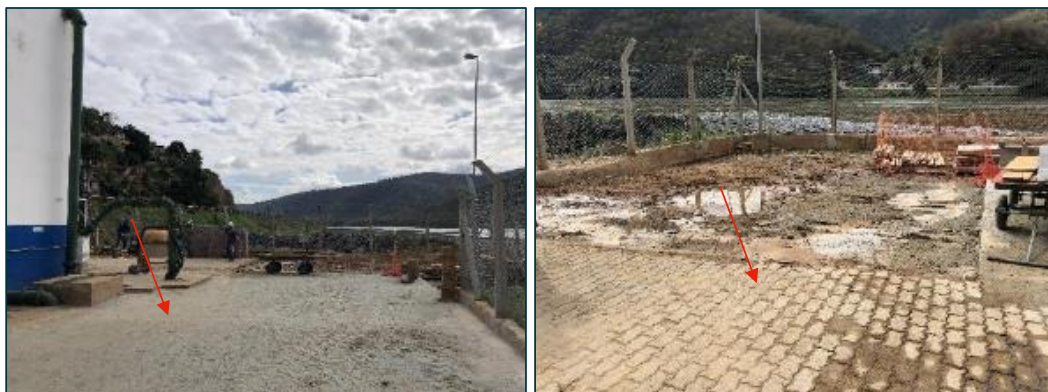
Figura 33: Execução de calçamento com piso paver (foto data: 06/06/2023).
