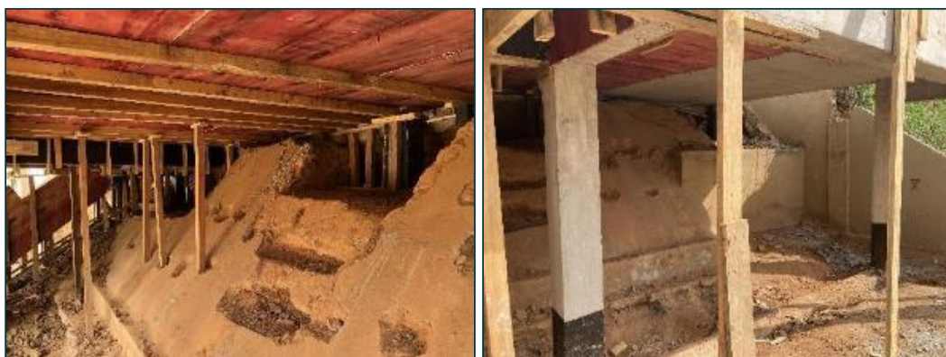
Figura 37: Escoramento das formas utilizadas para concretagem e talude abaixo do abrigo do sistema de pré-cloração (foto data: 06/06/2023).
