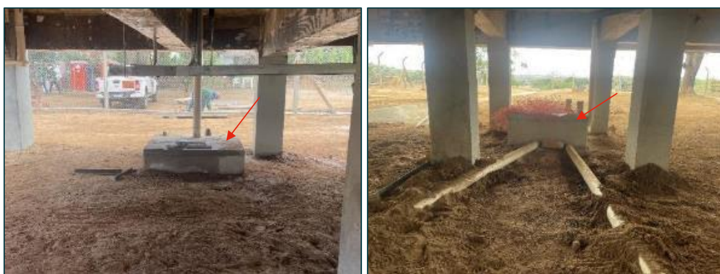
Figura 59: Caixas de passagem do sistema de esgoto (foto data: 06/06/2023).
