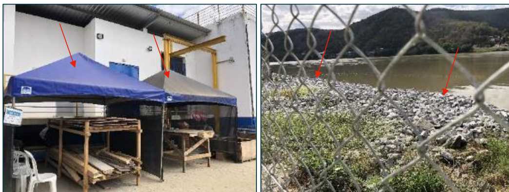
Figura 32: Área de vivência realocada e obra do enrocamento finalizada (foto data: 06/06/2023).
