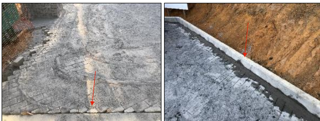
Figura 83: Execução de piso paver e guia de meio-fio na região externa ao STA (foto data: 05/06/2023).
